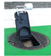
マンホールトイレ
